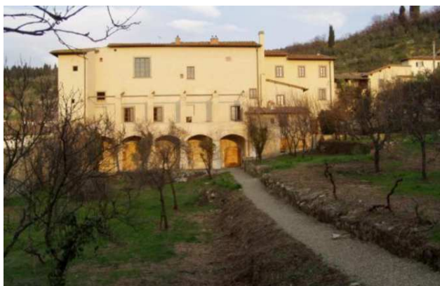
Figure 2, 3. Il Bigallo nel paesaggio del contado fiorentino. Il complesso visto dal giardino murato.
