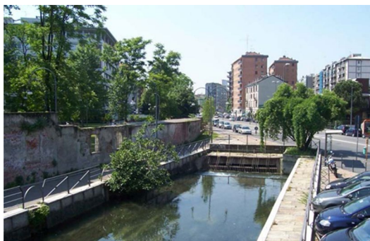
Fig. 7 – Via Melchiorre Gioia – Oggi: il Naviglio viene inghiottito al di sotto del manto stradale; il progetto: la sezione prospettica del nuovo boulevard lungo il Naviglio riaperto.
