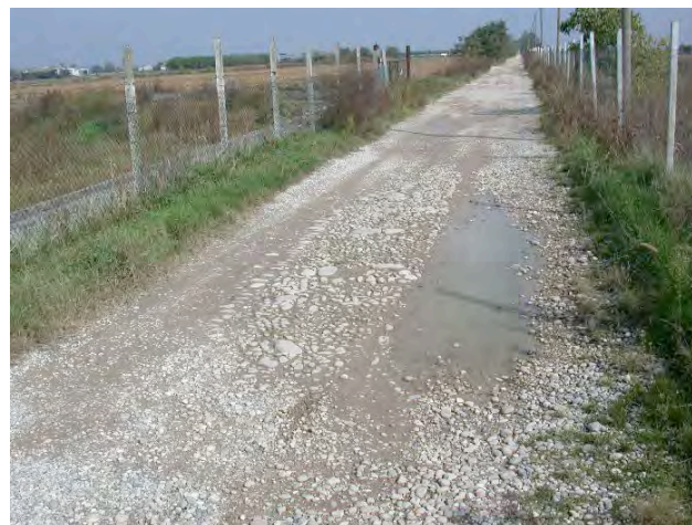
Figura 4. Il rettilineo della Postumia a nord ovest di Goito con tracce di ciottolato e giacitura in rilevato.
