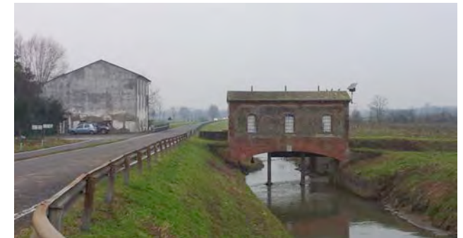
Figura 3. Il Dugale Delmona con un manufatto per la movimentazione delle chiuse, lungo la Postumia a ovest di Cremona.
