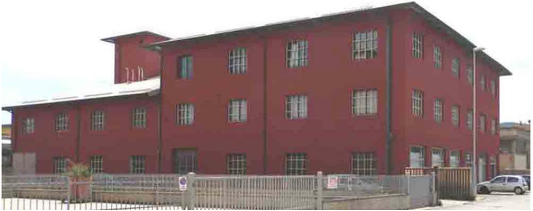
Fig. 10 – L'edificio recuperato ad uffici e showroom (foto: E. Spiotta).
