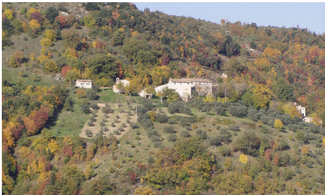
Fig. 4 – Il patrimonio edilizio rurale tradizionale, spesso realizzato con murature “povere” (frammenti di pietra, residui di laterizi, legante di malta aerea), ha subito gravissimi danni e, nella maggior parte dei casi, è irrecuperabile. Foto di Massimo Sargolini.
