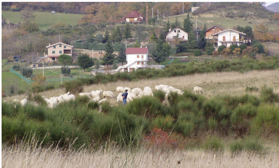
Fig. 3 – Alcuni manufatti danneggiati, pur ricadendo in area agricola pedemontana, non sono edifici rurali, tanto meno a servizio delle attività agro-silvo-pastorali tradizionali. Foto di Massimo Sargolini.
