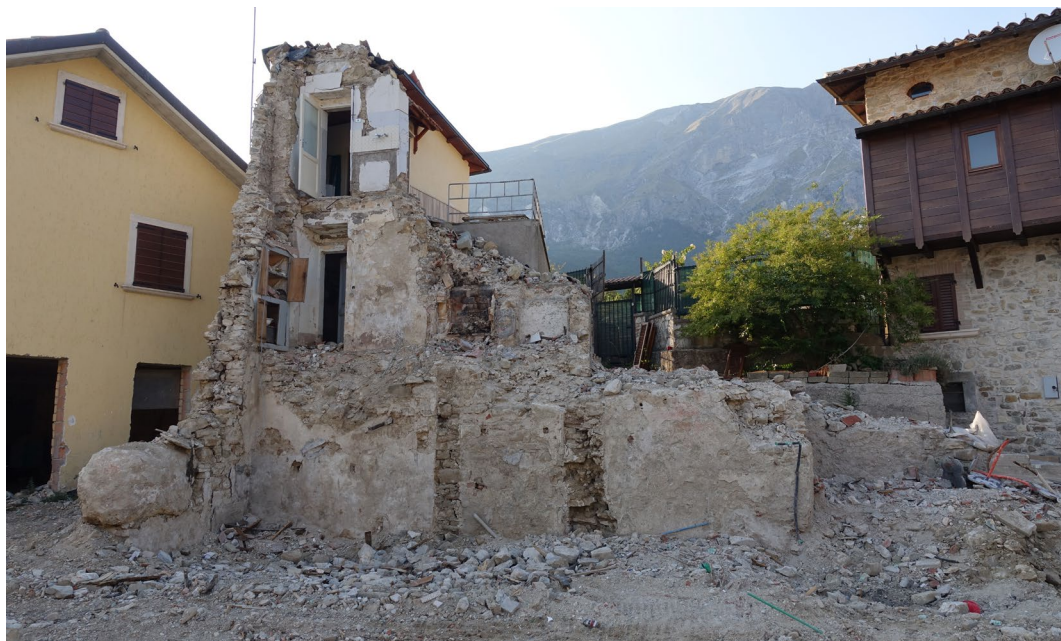
Fig. 1 – La ricostruzione può interessare un singolo edificio quando non è strutturalmente connesso con i volumi adiacenti. Foto di Massimo Sargolini.
