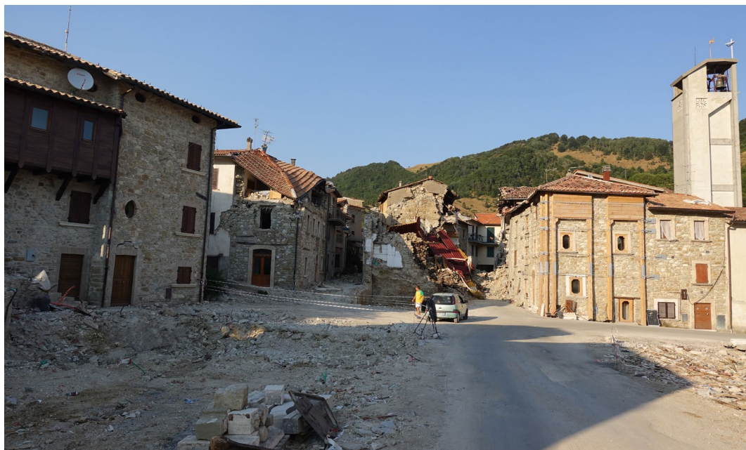
Fig. 2 – Nel caso in cui l'area che ha subito il danno è estesa e interessa parti di nucleo, le opere di ricostruzione riguardano anche le reti infrastrutturali e l'arredo urbano. Foto di Massimo Sargolini.
