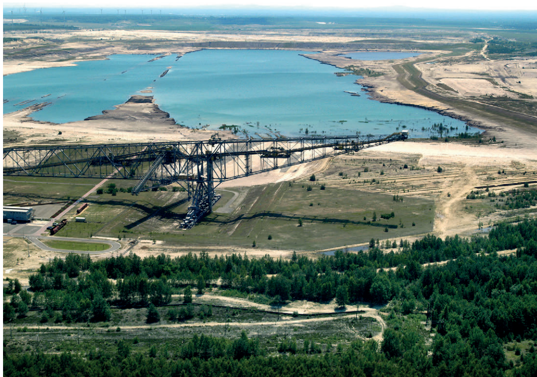
Fig. 5 – La cava a cielo aperto di Lichterfeld e il carroponte F60 durante la trasformazione dell'area per fini turistici. Lichterfeld, Germania, 2007 (foto: Lausitzer und Mitteldeutsche Bergbau-Verwaltungsgesellschaft, LMBV).
