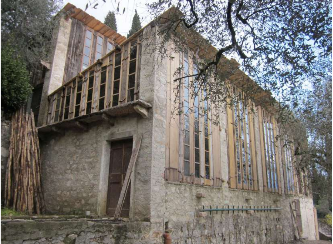
Fig. 6 – Una antica limonaia – qui chiusa per l’inverno – restaurata nel 2014 con particolare attenzione ai caratteri architettonici e materici storici (foto di Alberta Cazzani).
