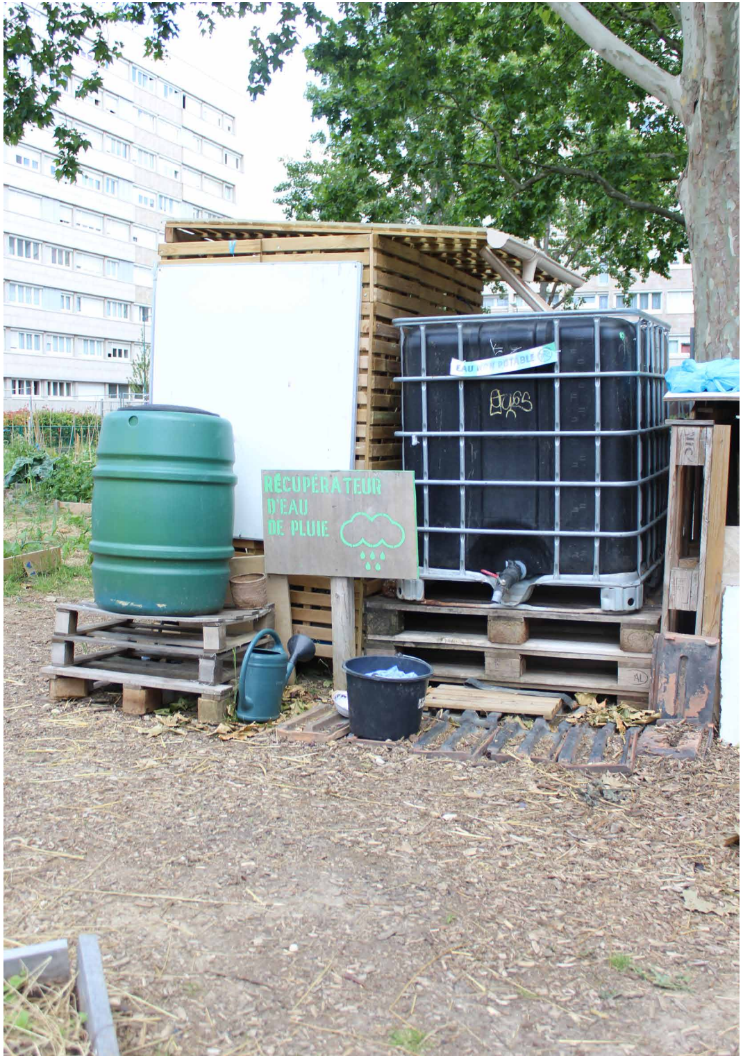
Fig.6 – Sistema di recupero delle acque grigie, auto costruito dalla cittadinanza e dai volontari.
