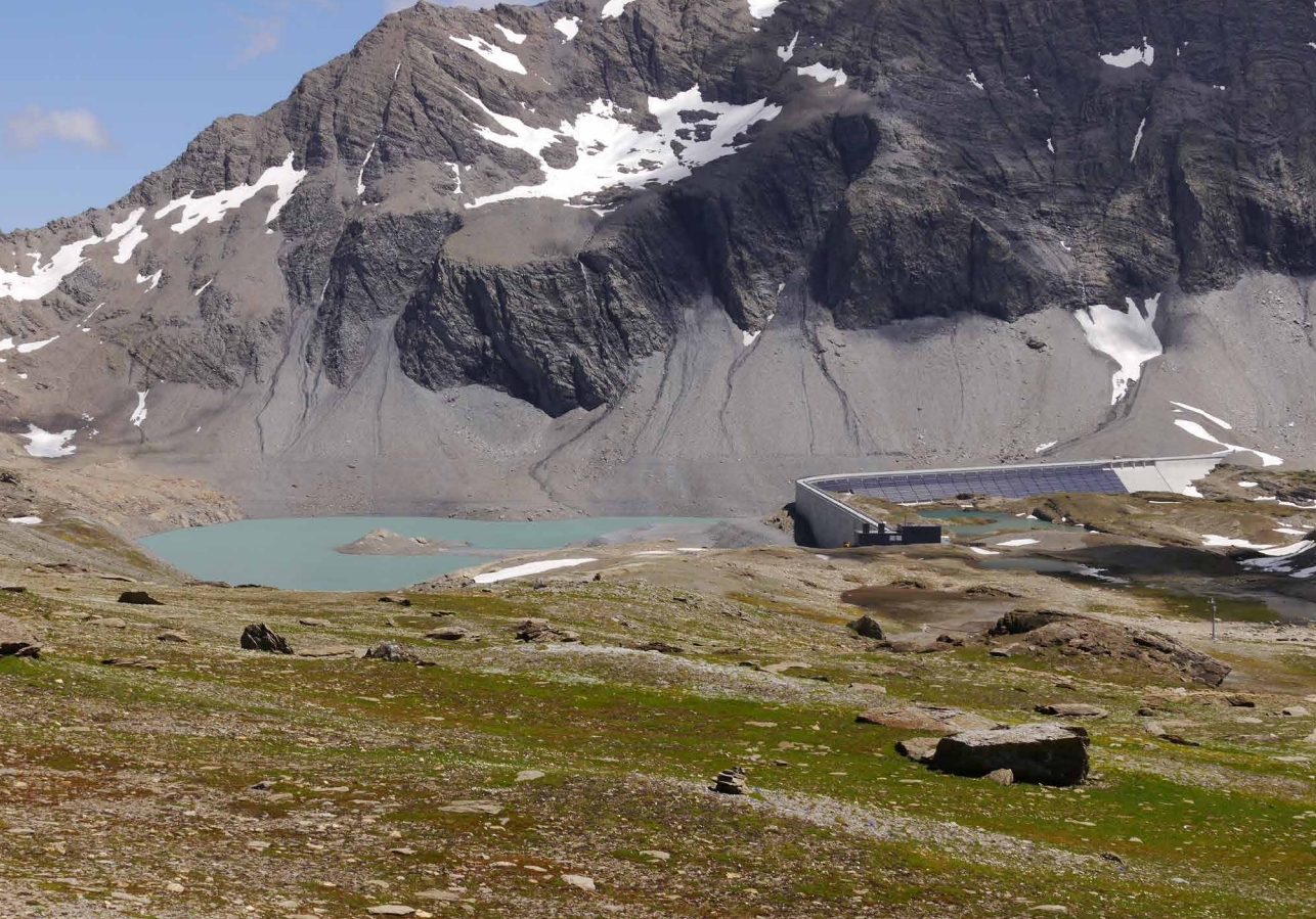
Fig. 2 - 'Diga solare' dell'invaso Muttsee che alimenta la centrale idroelettrica di Linthal, nelle Alpi Svizzere (foto: Dirk Oudes - cortesia dell'autore).
