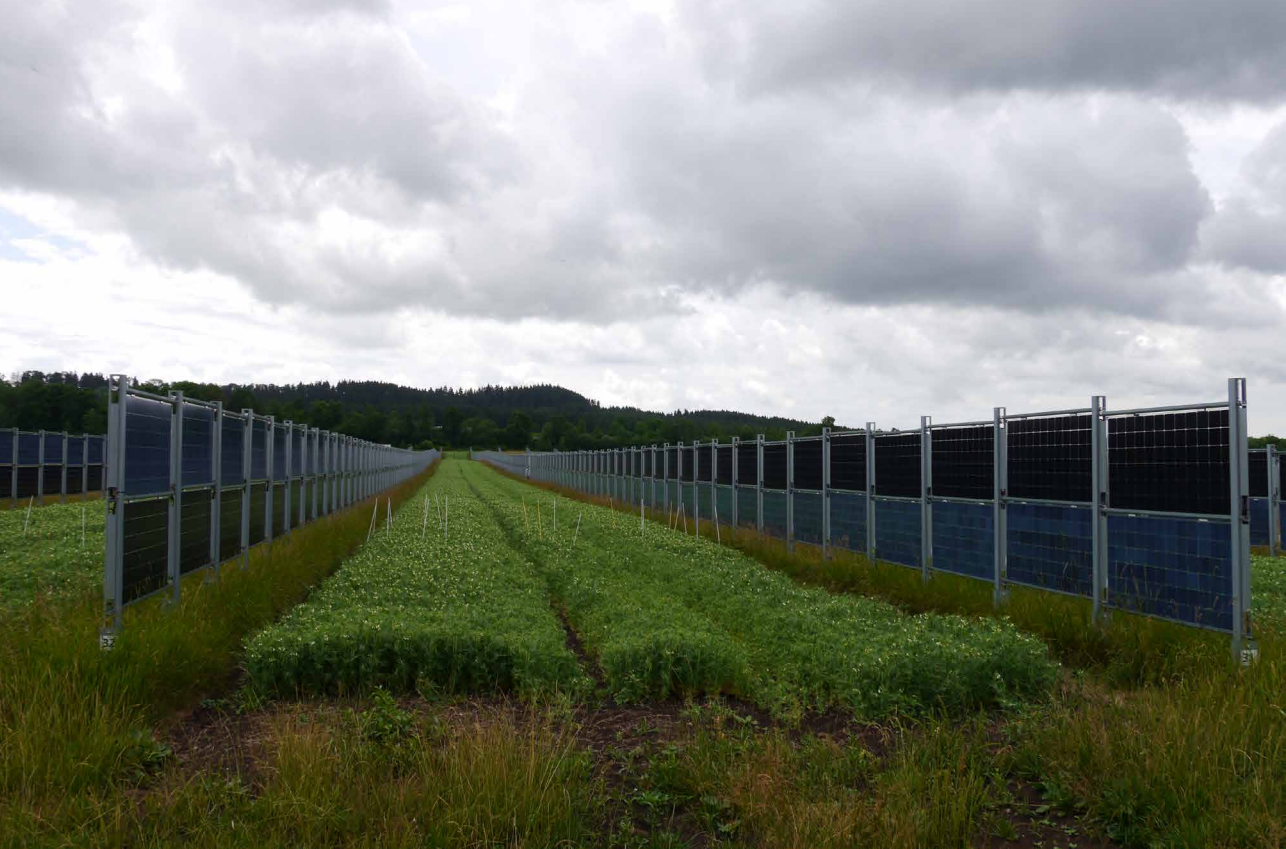
Fig. 3 - Combinazione della produzione agricola e di quella elettrica fotovoltaica a Donau-Eschingen, in Germania (foto: Sven Stremke - cortesia dell'autore)
