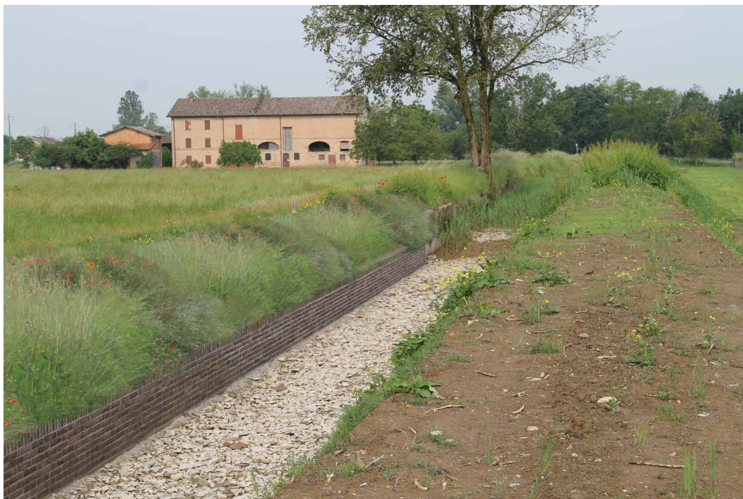
Fig. 7 – Il bordo spondale realizzato in laterizio scuro, proveniente da fornace locale, e il fondo in ciottolo di fiume costipato di limo, nel primo intervento pilota di 120 metri completato lungo il Canale Demaniale d'Enza. (Foto: Luca Filippi).
