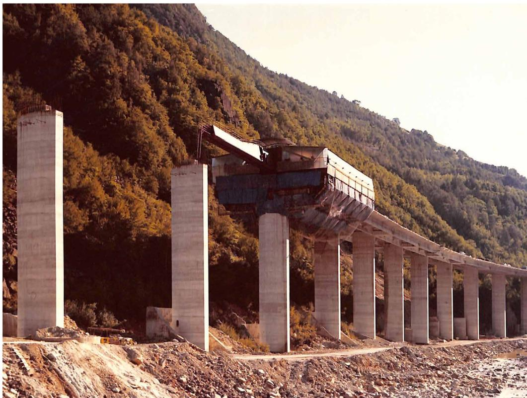
Fig. 2 - Viadotto Campodazzo: realizzazione impalcato, 1965/75 (foto: Chiolini & C., Pavia. Fondazione ing. Lino Gentilini).
