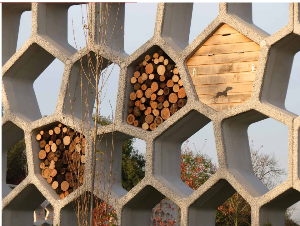
Fig. 13 - Maxismapark, Utrecht. Le cellule che la compongono la Park Pergola accolgono rifugi per pipistrelli e bugs hotel incrementando la presenza di biodiversità (foto: ©J. de Boer via Vrienden van het Maximapark).
