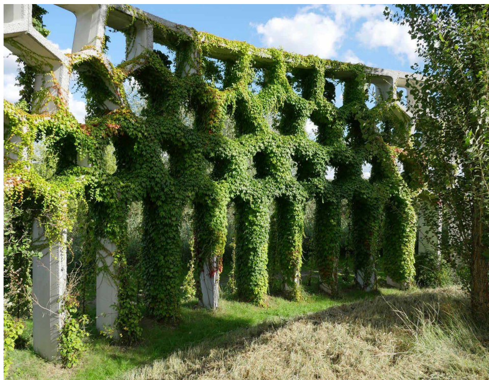
Fig. 14 - Maxismapark, Utrecht. Pensata per sostenere lo sviluppo di piante rampicanti, la Park Pergola verrà nel tempo sottoposta ad un processo di mimesi vegetale (foto ©J. de Boer via Vrienden van het Maximapark).
