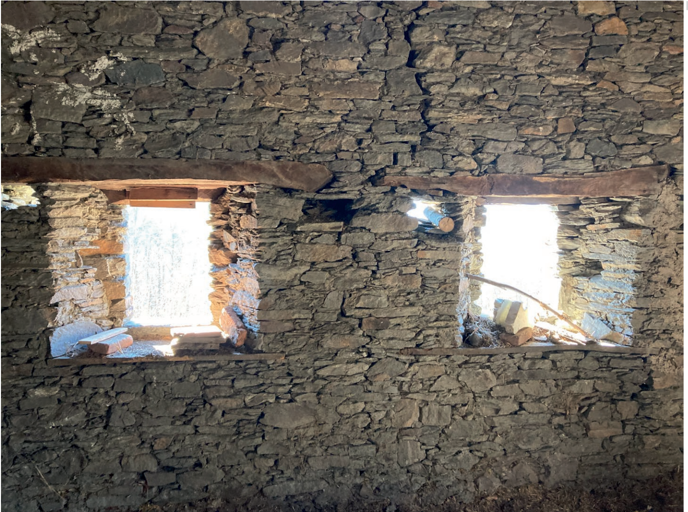
11 | Borgata storica in zona sismica, Villar Perosa (TO). Crediti fotografici: Andrea Veglia Historic hamlet in seismic zone, Villar Perosa (TO). Photo credits: Andrea Veglia
