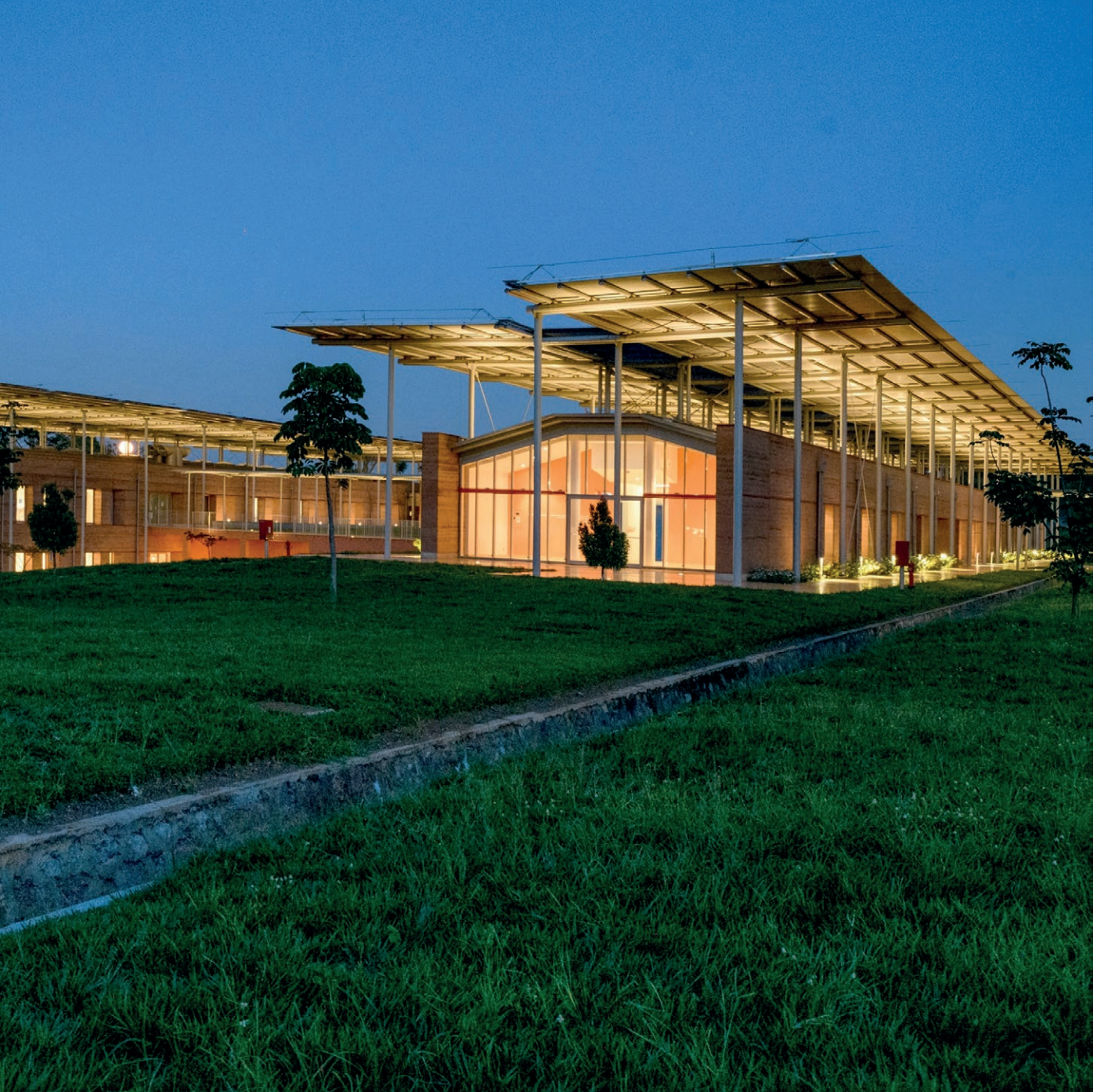
01 | Ospedale di chirurgia pediatrica di Emergency, Uganda. Progetto: RPBW, TAMassociati e Building Division di EMERGENCY; Progetto strutturale: Buro Milan; Crediti fotografici: Maurizio Milan
