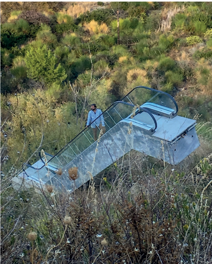
6 | Scala mobile, da "Incompiuto Siciliano" di Alterazioni Video, 2018, photo credit: Alterazioni Video Scala mobile, from "Incompiuto Siciliano" of Alterazioni Video, 2018, photo credit: Alterazioni Video
