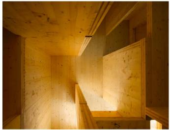
tute di Tsukuba in Giappone, una simulazione d'incendio su un edificio di tre piani «SOFIE» che ha dimostrato una resistenza della durata di un'ora conservando le sue proprietà meccaniche e lasciando inalterata la struttura portante, con prestazioni del tutto assimilabili a quelle di edifici in muratura o in c.a.
