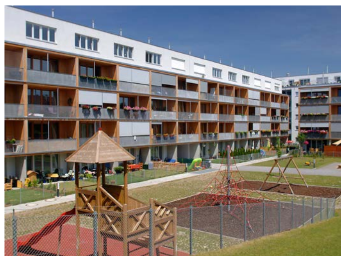
02 | Complesso residenziale «Spöttlgasse», Vienna. Edificio con struttura a pareti portanti mista in cls e legno. Housingcontest, Milan. CC Cabita Project; south elevation daily view.
