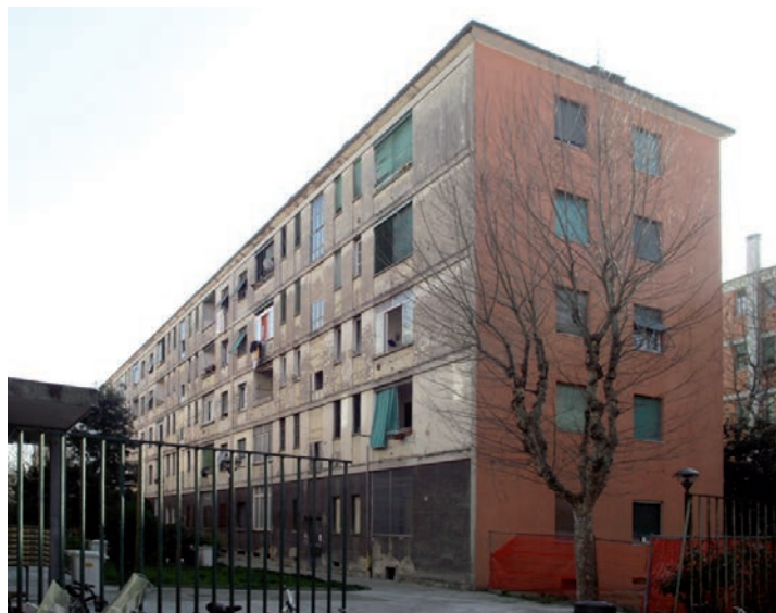
04 | Edifici di Albini, Camus e Palanti in corso di intervento (foto di Maria Fianchini). Blocks by Albini, Camus and Palanti under works (photo by Maria Fianchini).
