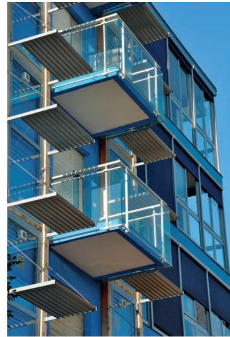
03 | Piazzale Moroni, Savona, dettaglio delle serre solari (a destra) e dei muri Trombe-Michel (a sinistra); sono visibili: i sistemi di ancoraggio, i frangisole, i ventilatori di sicurezza, i termostati e le bocchette di ventilazione nel collettore (foto di Andrea Giachetta). Piazzale Moroni, Savona, detail of the solar glasshouses (to the right) and Trombe-Michel walls (to the left).
