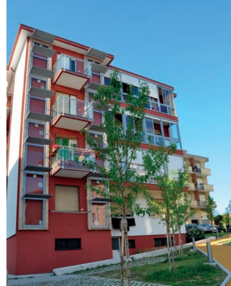
01 | Piazzale Moroni, Savona, edificio in via Roveda 2 dopo l'intervento di riqualificazione (foto di Andrea Giachetta).
