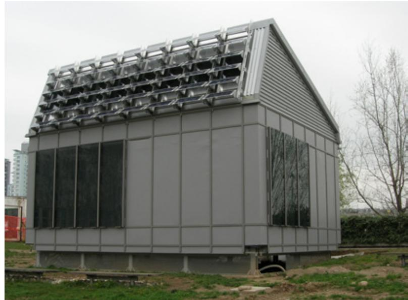
copertura a doppia falda è realizzata con pannelli in legno e rivestita con lamiera grecata (Fig. 5).
