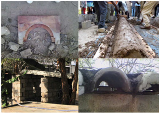
08 | Da sinistra a destra e dall'alto in basso: sagome di legno per la profilatura dei tegoloni all'intradosso e all'estradosso; profilatura della forma inferiore; vista del sito di esercitazione durante una pausa; dettaglio dei tegoloni durante l'applicazione del conglomerato di segatura e cemento all'estradosso. (Foto: Gian Luca Brunetti, licenza Creative Commons)
