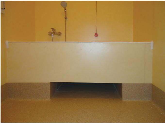
04 | Particolare dell'incavo sotto la vasca che permette l'utilizzo del sollevatore portatile
