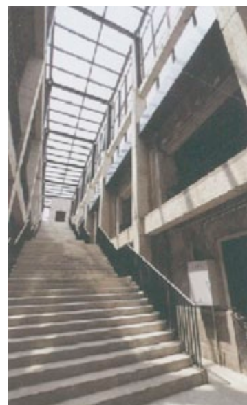
02 | 1933 Old Millfun dopo la ristrutturazione 6 1933 Old Millfun after renovation 6
