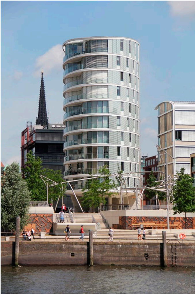
05 | Mix tipologico e funzionale ad Hafen City , Amburgo: l' Oval am Kaiser Kai (2007-2008) di Christoph Ingenhoven (© Matteo Moscatelli) e la Marco Polo Tower (2009-2010) di Behnisch Architekten (© Matteo Moscatelli)
