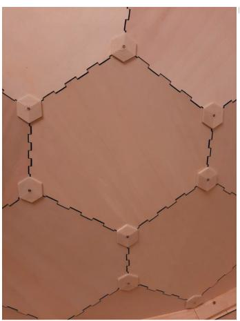
La ECHO shell è complessivamente realizzata da 94 pannelli connessi attraverso 144 connessioni. Nonostante la composizione simmetrica, le 144 connessioni sono tutte diverse, pertanto, la progettazione parametrica è stata fondamentale per evitare errori e progettarle e realizzarle in tempi ridotti (Fig. 4).
