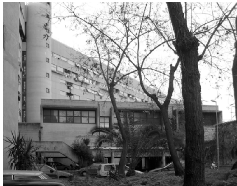
02 | Edilizia residenziale Roma Vigne Nuove, 1971-79; (foto di Daniele Frediani). Housing Roma Vigne Nuove, 1971-79; (photo by Daniele Frediani).
