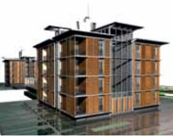
01 | Due edifici residenziali pubblici bioclimatici per 31 alloggi a Lunghezza 2, Roma (Capogruppo Thomas Herzog). Vista d'insieme dei due edifici caratterizzati da atri bioclimatici a tutta altezza e da involucri dinamici. Two bioclimatic social housing buildings with 31 dwellings in Lunghezza 2, Rome (Lead Designer Thomas Herzog). General view of the two buildings characterized by full length bioclimatic atriums and by a dynamic building skin.
