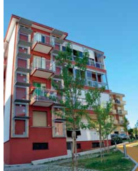
01 | Piazzale Moroni, Savona, edificio in via Roveda 2 dopo l'intervento di riqualificazione (foto di Andrea Giachetta).
