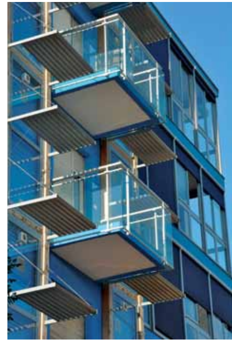
03 | Piazzale Moroni, Savona, dettaglio delle serre solari (a destra) e dei muri Trombe-Michel (a sinistra); sono visibili: i sistemi di ancoraggio, i frangisole, i ventilatori di sicurezza, i termostati e le bocchette di ventilazione nel collettore (foto di Andrea Giachetta). Piazzale Moroni, Savona, detail of the solar glasshouses (to the right) and Trombe-Michel walls (to the left).
