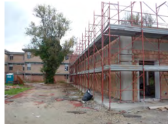
15 | Liceo Scientifico Majorana: Fase di cantiere. Prospetto nord Majorana School: construction of north façade
