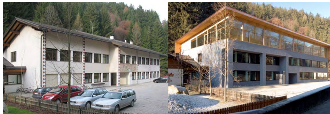
03 | Intervento di riqualificazione profonda della scuola primaria di Casteldarne del Comune di Chienes (a sinistra, prima dell'intervento; a destra, dopo l'intervento). La sopraelevazione, realizzata con tecnologie leggere stratificate a secco, ospita un open space utilizzato, sia per la scuola, sia per le associazioni locali. Inoltre, la biblioteca situata al piano terra può essere raggiunta dall'interno da parte degli studenti, come pure attraverso una porta direttamente comunicante con l'esterno che la rende autonoma rispetto agli orari della didattica. Foto di EM2 Architetti.
