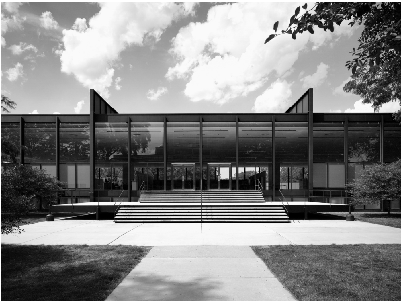
03 | Mies van der Rohe, Crown Hall, Chicago
