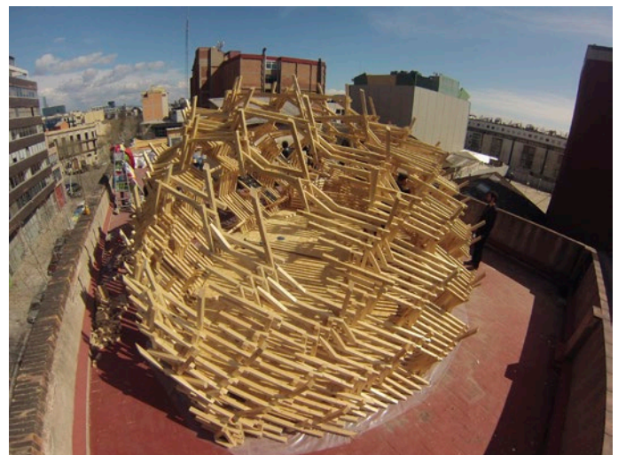
05 | Padiglione Digital Urban Orchard installato sulla copertura piana dell'università, foto di Andrea Quartara.
