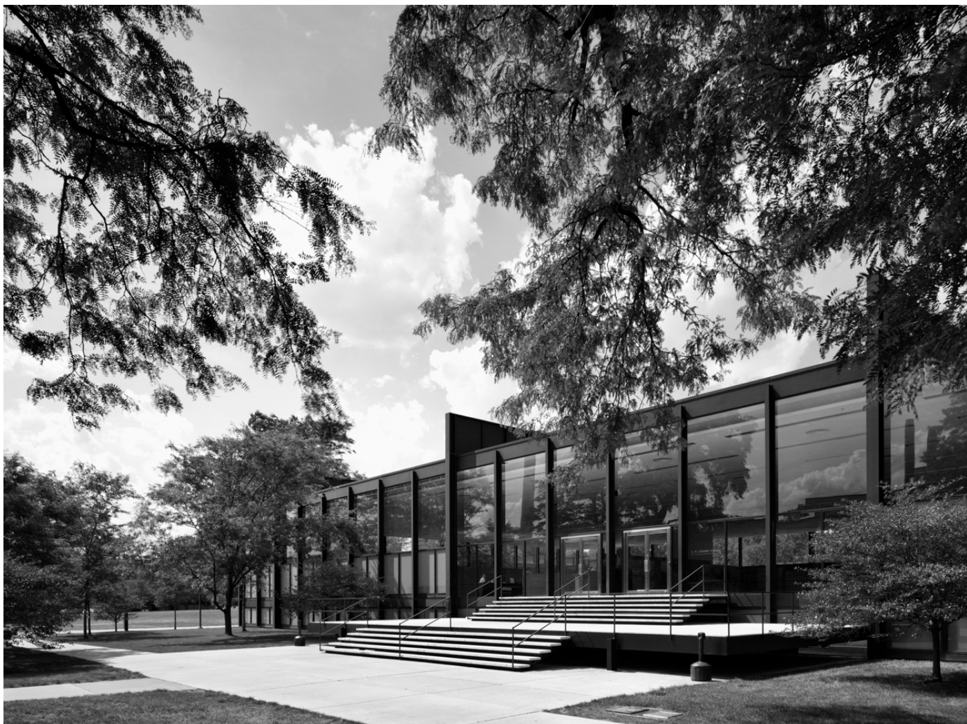
02 | Mies van der Rohe, Crown Hall, Chicago
