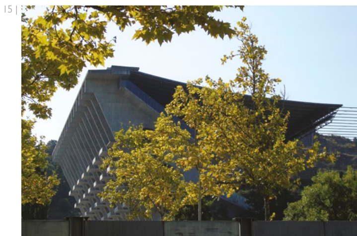
15 | Stadio Municipale, Braga, Portogallo, 2000-2003 (foto di Francesco Cancelliere) Braga Stadium, Portugal, 2000-2003 (photo by Francesco Cancelliere)
