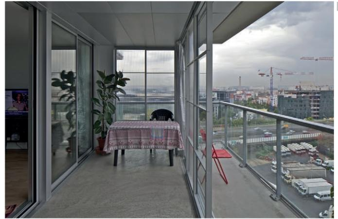
sul limite dell'alloggio da vetrate scorrevoli con serramenti di alluminio. Durante il periodo estivo, invece, il modulo prefabbricato si tramuta in loggia, totalmente aperta alla ventilazione e al ricambio d'aria e ombreggiata da tende oscuranti all'esterno e tende termiche sul limite dell'alloggio.
