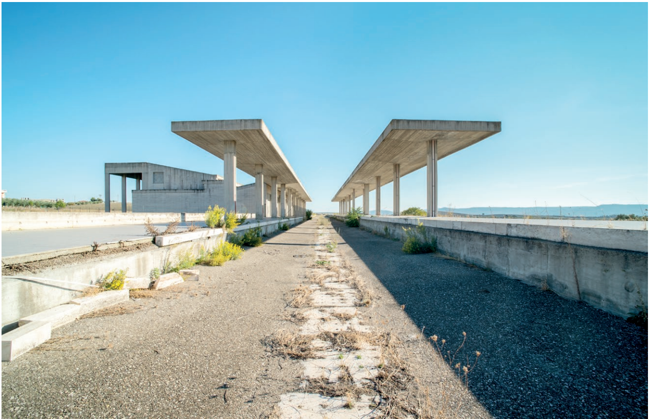
1 | Stazione La Matella, Matera, da "Incompiuto Siciliano" di Alterazioni Video, 2018, photo credit: Alterazioni Video La Matella station, Matera, from "Incompiuto Siciliano" of Alterazioni Video, 2018, photo credit: Alterazioni Video
